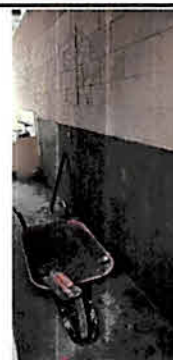
Foto 6: Filtración de agua externa en muro perimetral
