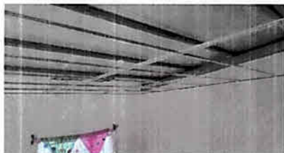
Foto1: Instalación de cielo falso
