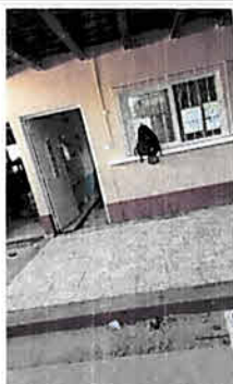
Foto 3: Sustitución de piso en mal estado
